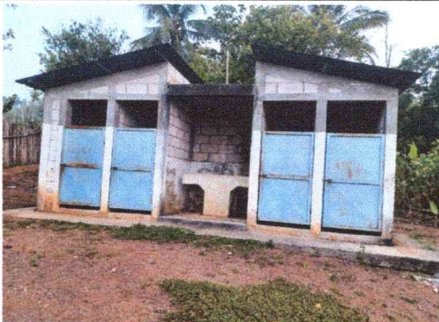
Foto 5: Instacion de puerta para baños que ocupa el establecimiento
