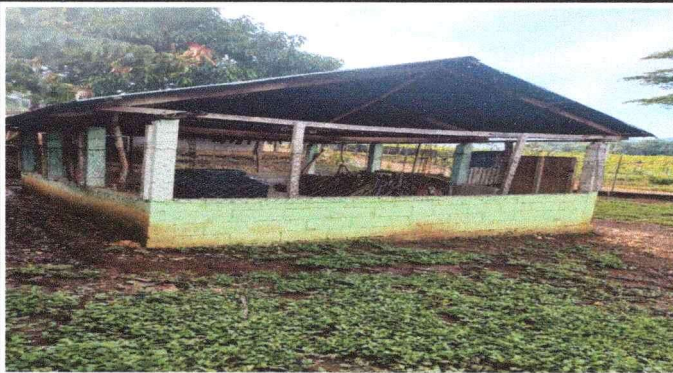
Foto 3: Se observa la necesidad de reparar o sustitucion de la cocina.
